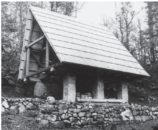
Bijele stijene - Kuća 1967. god. - Izgradnja
